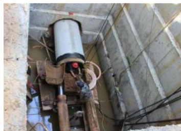
(e) 深基坑和地下管沟
