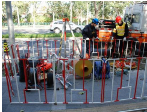
图 4-2 作业现场围挡
