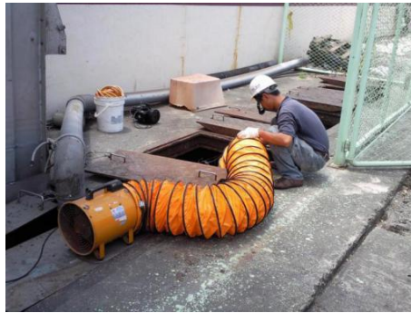
图 4-6 风机、风管的设置
